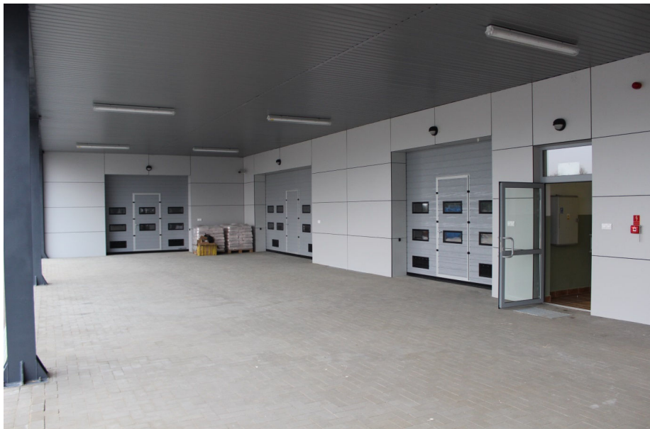
Rampa rozładunkowa i budynek gospodarczy
