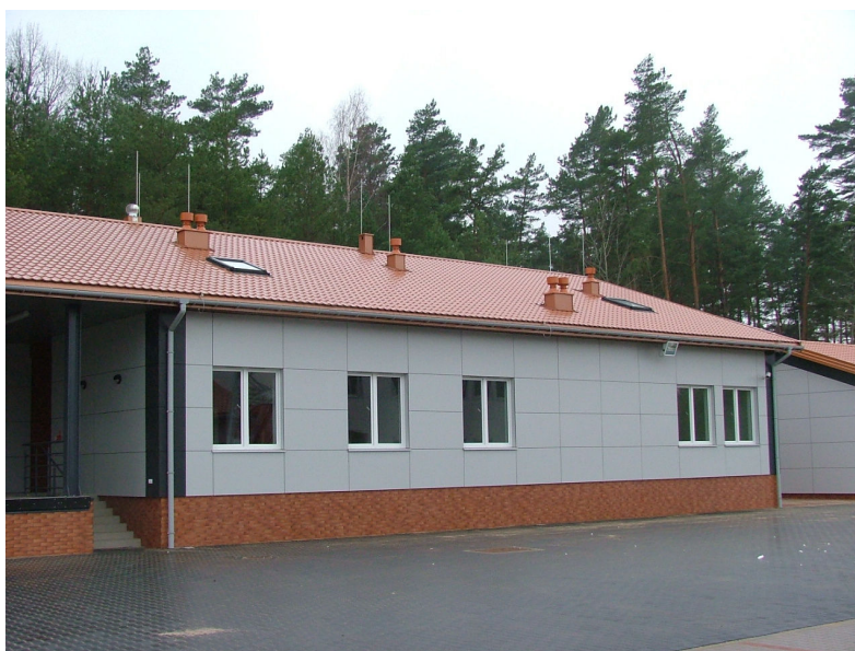
Budynek służb fitosanitarnych
