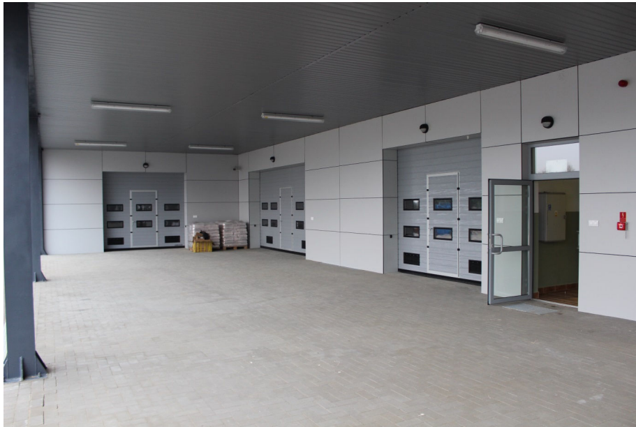
Rampa rozładunkowa i budynek gospodarczy
