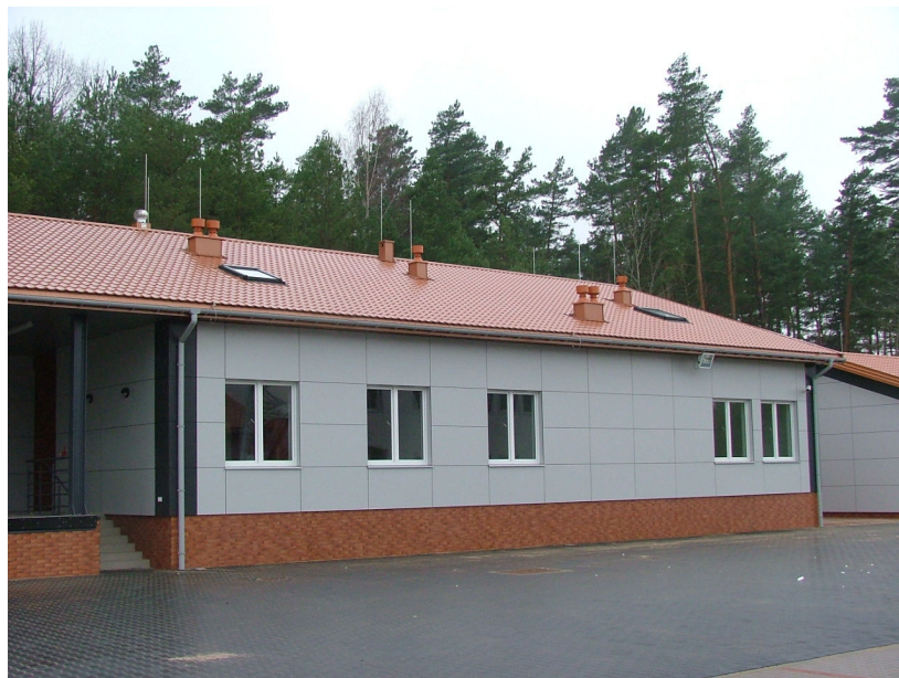
Budynek służb fitosanitarnych
