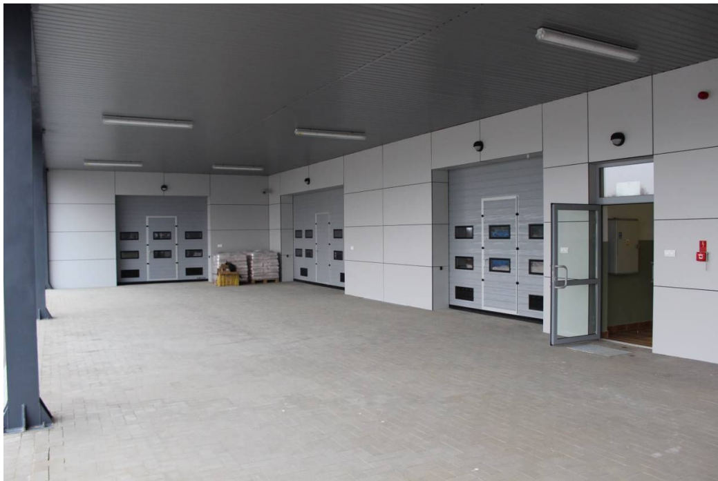
Rampa rozładunkowa i budynek gospodarczy
