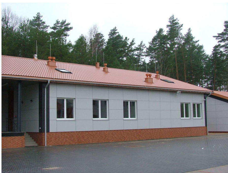
Budynek służb fitosanitarnych
