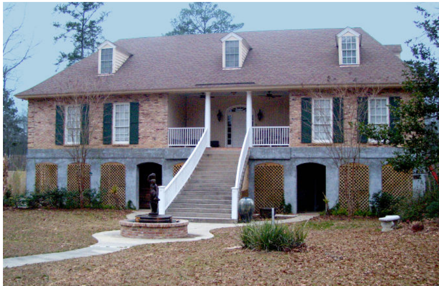
Rys. 6. Budynek z dolną kondygnacją przystosowaną do okresowego zalewania przez powódź.
